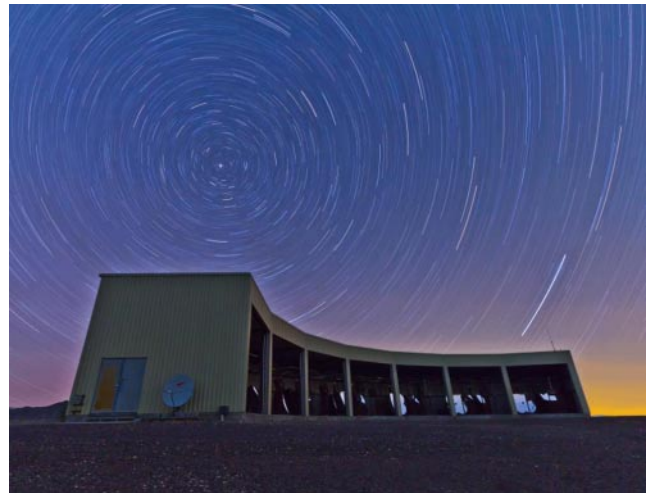
Рис. 4. Станция Middle Drum, состоящая из 14 телескопов, регистрирующих флуоресцентное послесвечение атмосферы. Ночной снимок с большой экспозицией, предоставленный Б. Стоксом.
